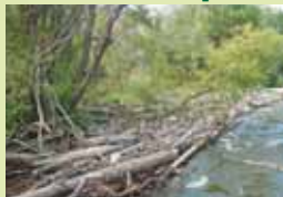
До начала работ
